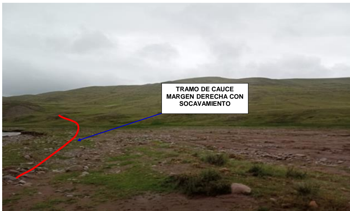
FIGURA N° 02: QUEBRADA CHALLHUANCA EXPUESTO ANTE UNA CRECIDA CON SOCAVAMIENTO EN LA ZONA PLANA.
